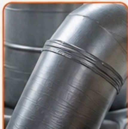
SELLADO DE DUCTOS
